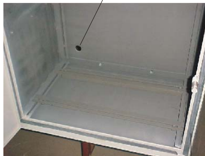
Furo de 21mm de diâmetro, na tampa posterior para passagem do eletroduto com a fixação da medição
