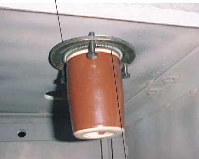
Anel-mola para fixação da bucha Na caixa
